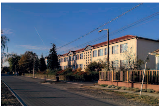
Malom utcai Általános Iskola (helyi védett épület)
